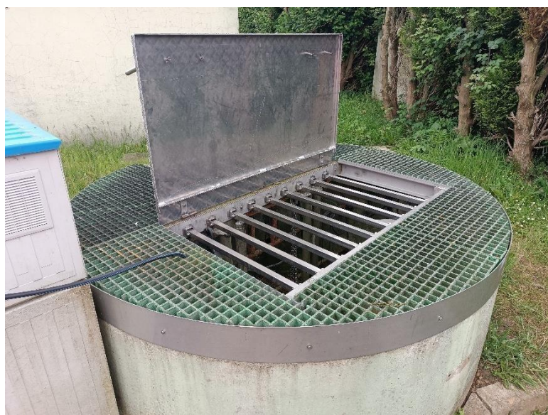
Mise en place de barres anti chute au poste d'arrivée des effluents bruts à la station d'épuration d'Helfaut
