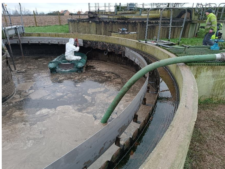
Changement de la lame déversante dans le clarificateur à la station d'épuration d'Helfaut
