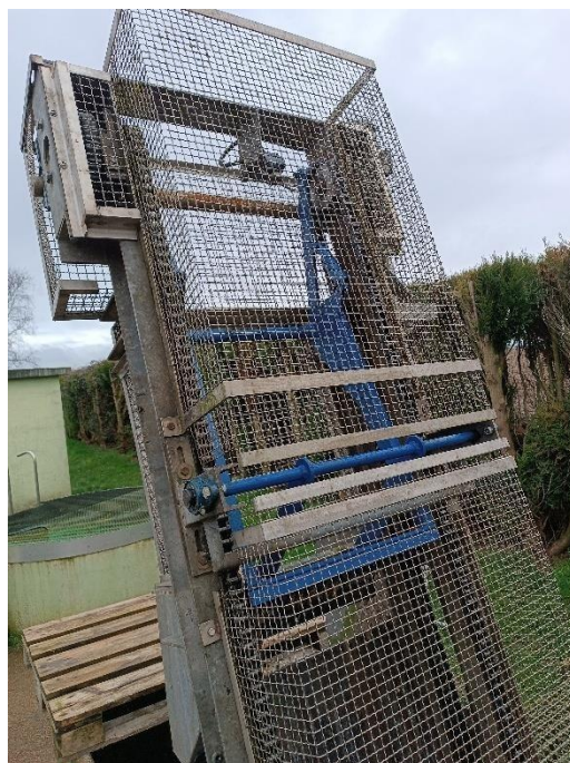
Sécurisation du dégrilleur à la station d'épuration d'Helfaut
