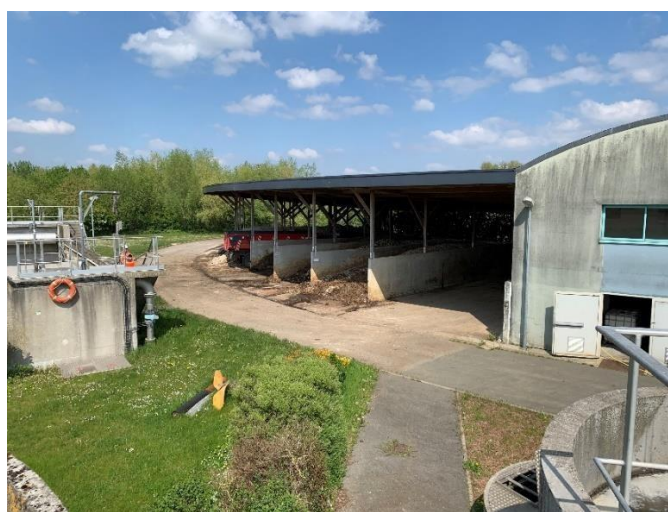
Stockage cloisonné des boues
