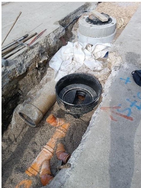
Pose d'un réseau E.U. et pluvial
