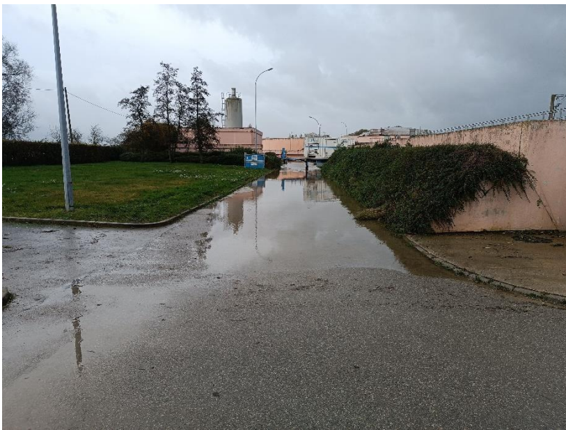
Station d'épuration de St Omer
