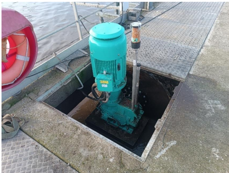
Renouvellement des motoréducteurs des 4 ponts brosses à la station d'épuration de Arques
