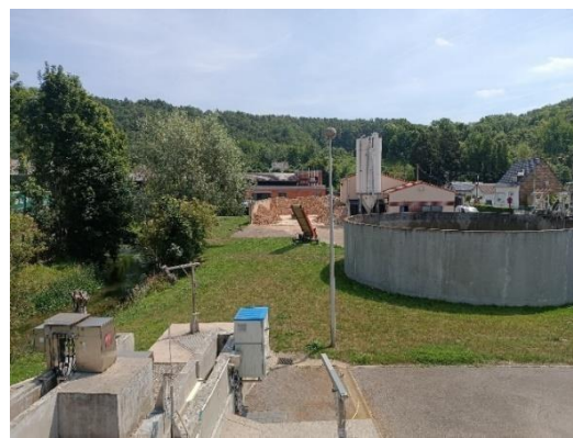
Stockage des boues
